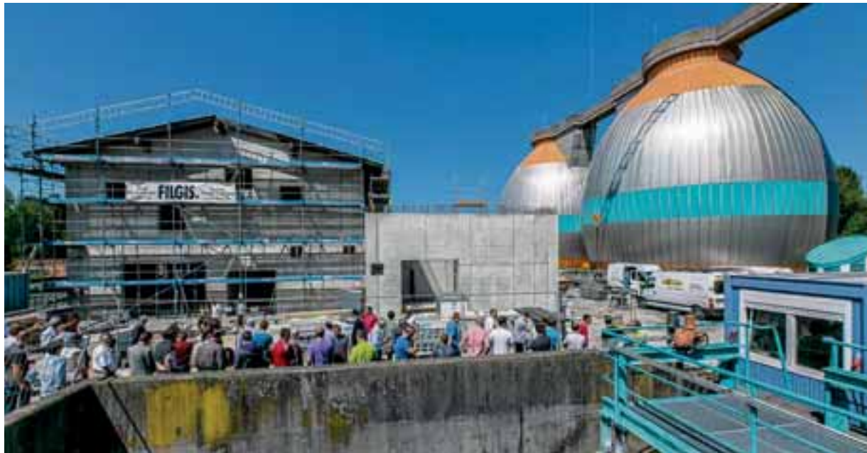
Richtfest am Klärwerk des Abwasserverbands Kempten in Lauben: Sechs Millionen Euro fließen in eine Kläranlage und den Bau eines Blockheizkraftwerks. Baubeginn war im August. Im September soll die Anlage ans Netz gehen.
