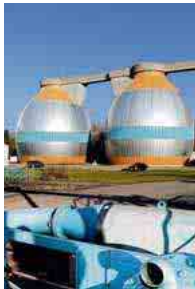
Ein Blick auf die Faultürme des Gruppenklärwerks in Lauben. Archivfoto: Ernst
