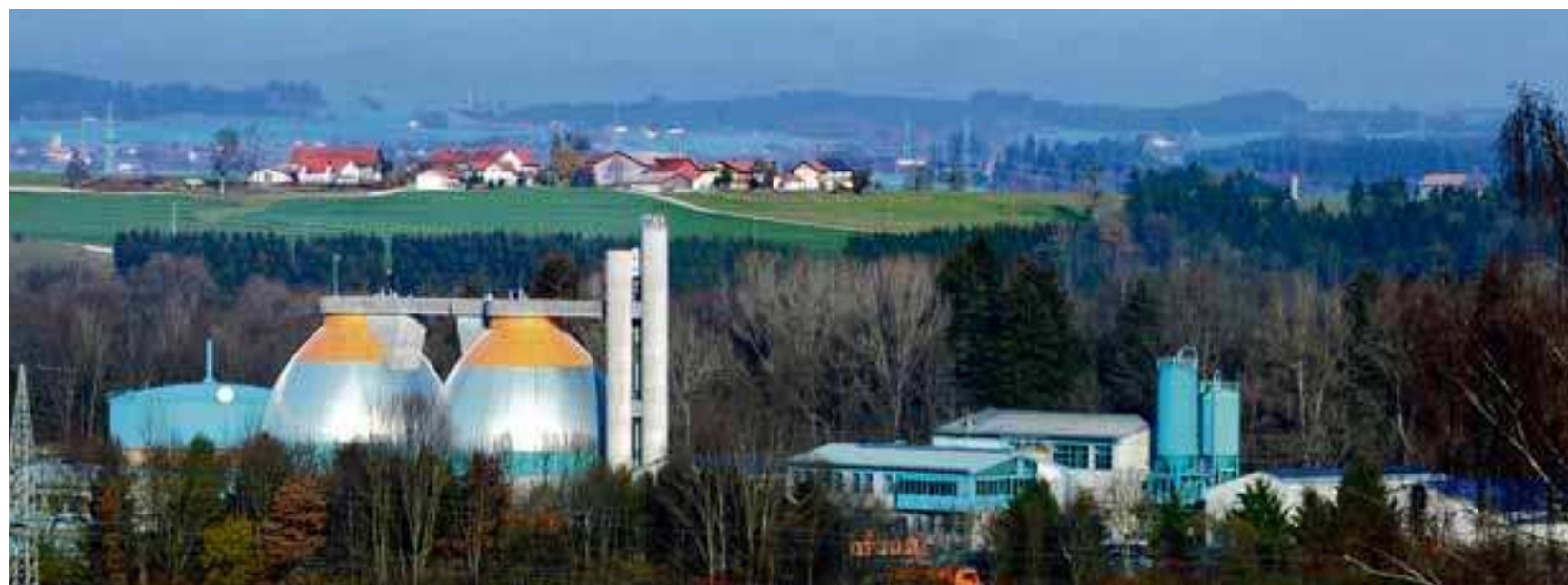
Ein modernes Klärwerk steht in Lauben. Der frühere Betriebsleiter Rudolf Bader zeigte sich stolz darauf, dass die Anlage immer das Interesse von Fachleuten aus dem In- und Ausland auf sich zog. Fotos: Hermann Ernst
