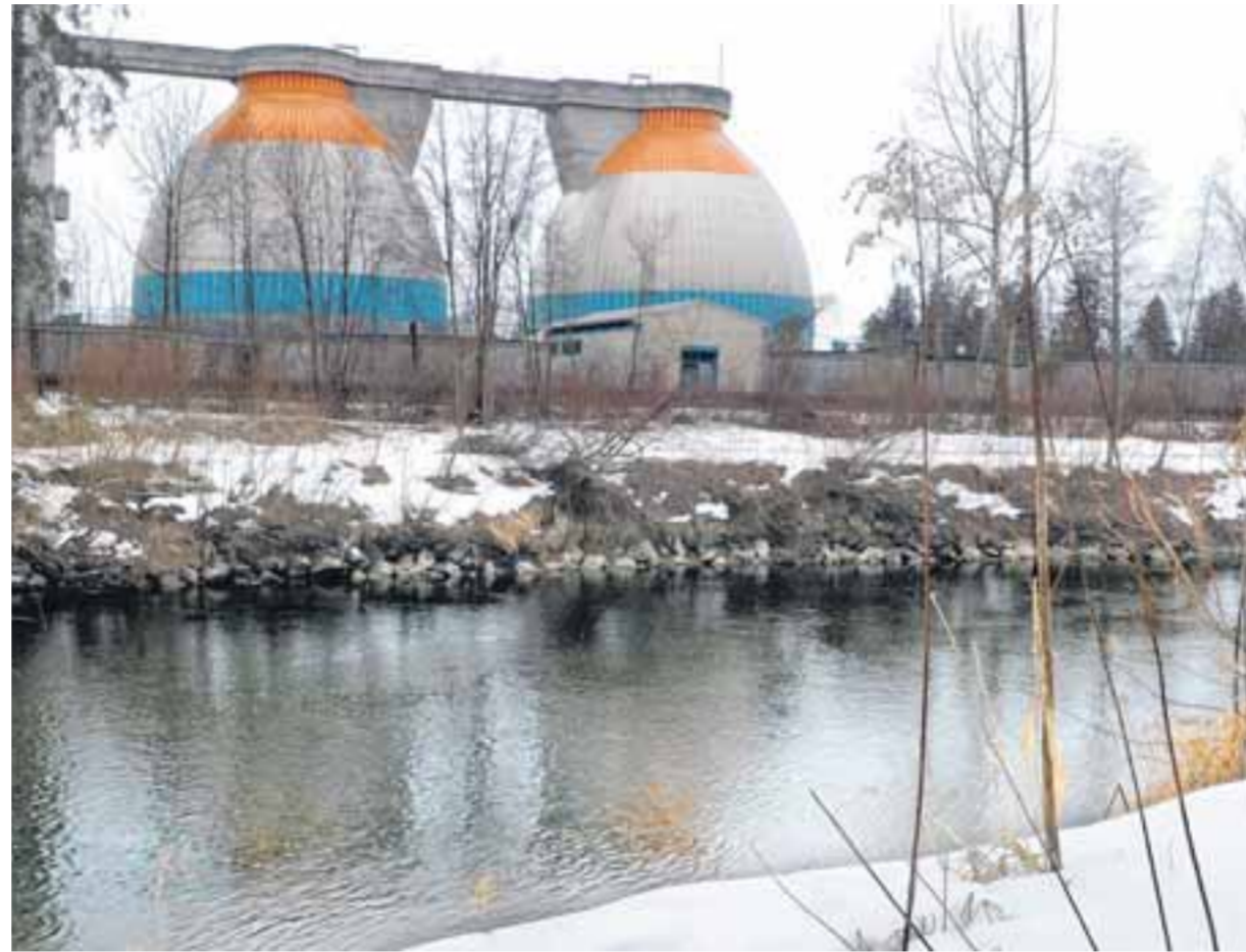
Das geklärte Abwasser aus elf Gemeinden und der Stadt Kempten fließt bei Lauben wieder in die Iller. Durch eine Modernisierung der Kläranlage ist es nun aber möglich, Stickstoff noch besser aus dem Abwasser zu filtern. Foto: Hermann Ernst
