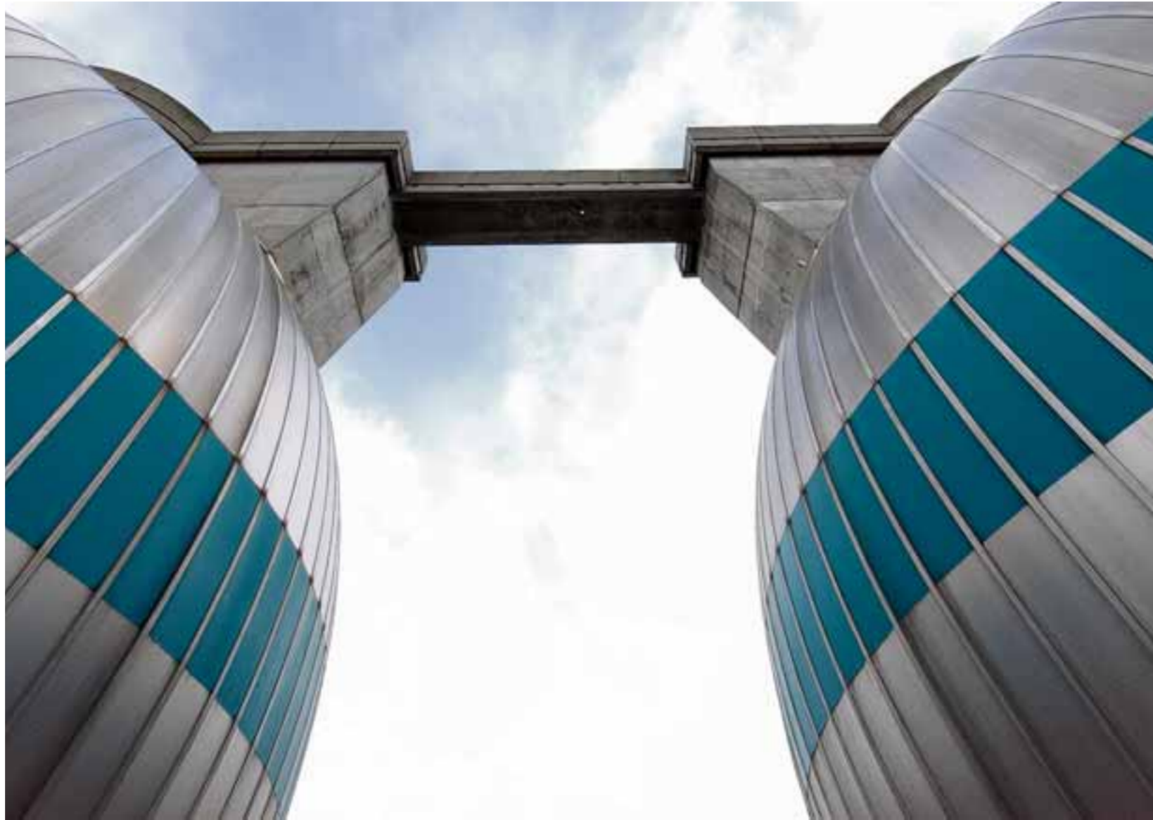
Interessante Perspektiven bietet das Gruppenklärwerk des ZAK in Lauben. Die Anlage wird im nächsten Jahr modernisiert, sodass künftig 85 Prozent des Stroms durch Klärgas selbst erzeugt wird. Foto: Jörg Schollenbruch
