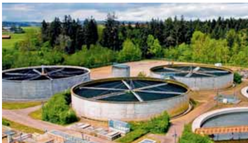
Die neue Tropfkörperanlage (links) ist schon mit Kunststoff zur Abwasserreinigung befüllt, die beiden anderen Anlagen bekommen diese Füllung demnächst. Kostenpunkt: 1,7 Millionen Euro. Archivfoto: Hermann Ernst
