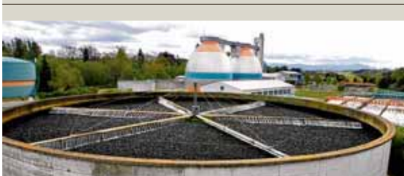
Eine der beiden alten Tropfkörperanlagen (Vordergrund), die demnächst ein neues Innenleben erhalten, im Hintergrund die Faultürme. Foto: Hermann Ernst
